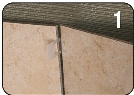
Glissez deux clips sous le carreau et dans le mortier à une distance d'environ 50 mm de chaque extrémité du carreau. Posez la deuxième dalle.
