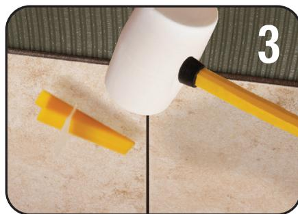
Une fois que le mortier a durci, tapotez les clips avec un maillet en caoutchouc non marquant pour qu'ils se cassent aux points de rupture spécialement désignés. Gardez les cales pour les utiliser à nouveau.
