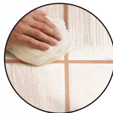
**AYUDA A REMOVER LOS RESIDUOS DE REJUNTADO DESPUÉS DE LA INSTALACIÓN DE LAS LOSETAS**
