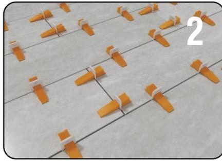
Deslice la cuña reusable en las anclas para nivelar, alinear, espaciar y sostener las losetas.
