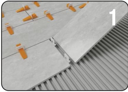
Deslice dos anclas debajo de la loseta en el mortero aproximadamente a (2") de cada extremo de la loseta. Coloque la segunda loseta.
