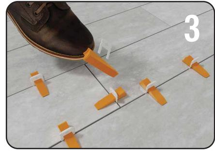
Una vez el mortero se haya asentado, simplemente golpee suavemente las anclas con un martillo de goma para que se quiebren en los puntos de quiebre especialmente diseñados. Guarde las cuñas para utilizarlas de nuevo en el futuro.
